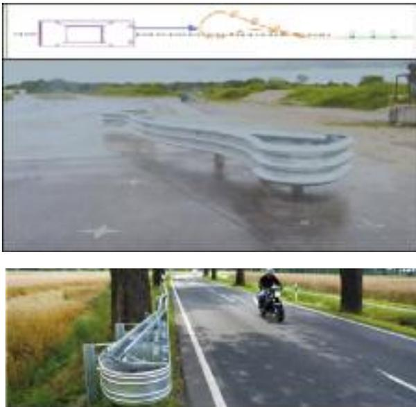
Fig. 8 • Esempi di barriere per protezioni “puntuali”
